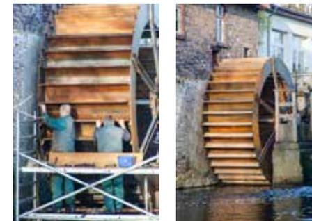
Der komplexe Einbau des Mühlrads musste dabei in Etappen erfolgen: Zuerst wurde die Welle eingebaut, anschließend folgten die Betonarbeiten, ehe zuletzt das Mühlrad zusammengesetzt und montiert werden konnte.
